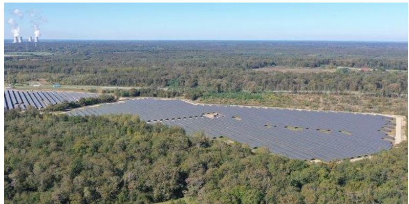
Figure 3: centrale solaire à Gien (Loiret), une des plus grosses centrales de France - Crédits : Totalenergies
